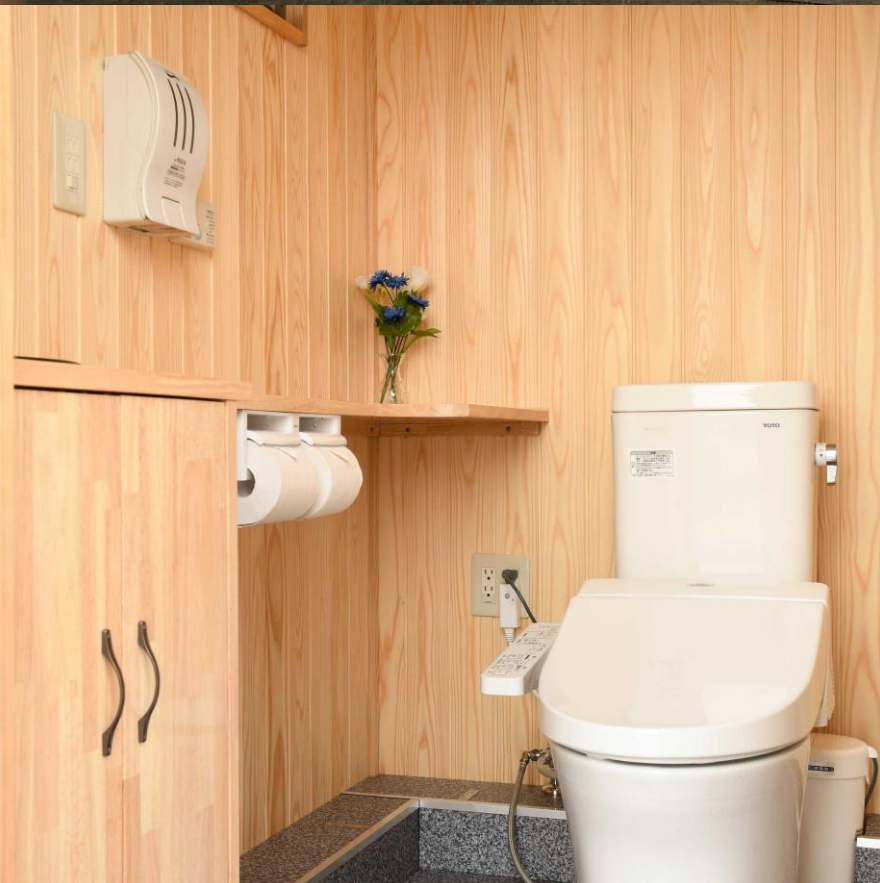
水を流すとSFAポンプ“サニアクセス3”が起動し、排水を粉碎し、別タンクに圧送します。
